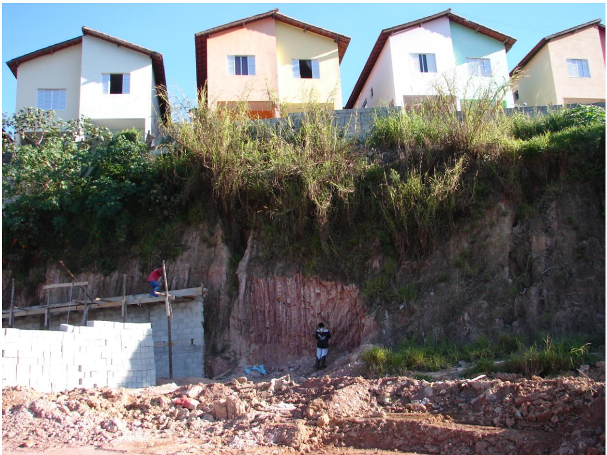
Foto 4 - Corte de talude, com presença de muro de contenção inadequado na base e de moradias no topo.
