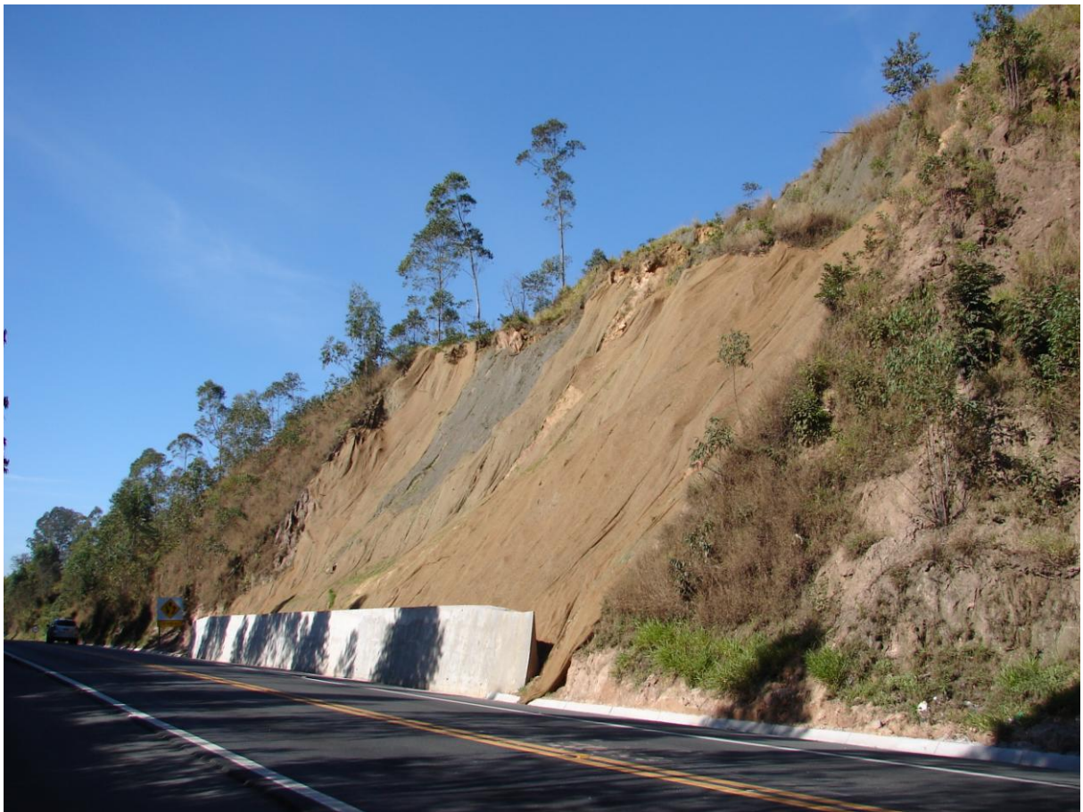
Foto 3 – Escorregamento em talude da rodovia SP-354.
