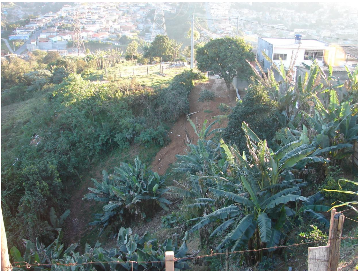
Foto 5 - Escorregamento em aterro. Há presença de lixo, entulho e bananeiras na encosta, que favorecem o acúmulo de água.
